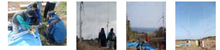
対馬での海洋レーダ設置作業
